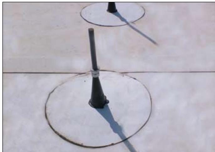
Il raccordo conico è stato a sua volta sigillato con DERBIMASTIC S.
